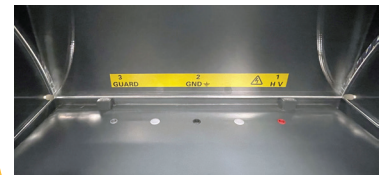
Raccordement sur bornes internes de l'équipement à tester
