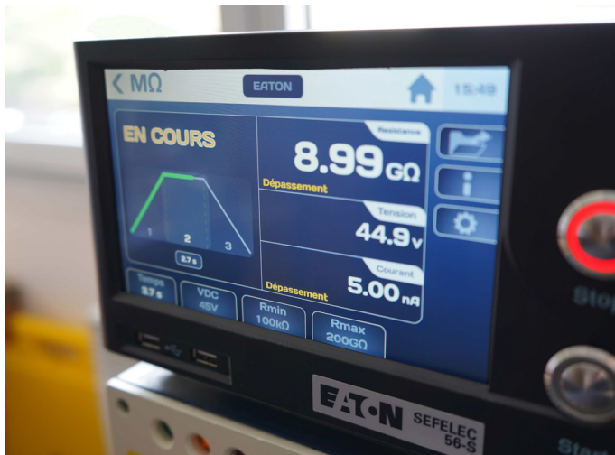
SEFELEC 56-S en cours de mesure d'isolement sous 45V
